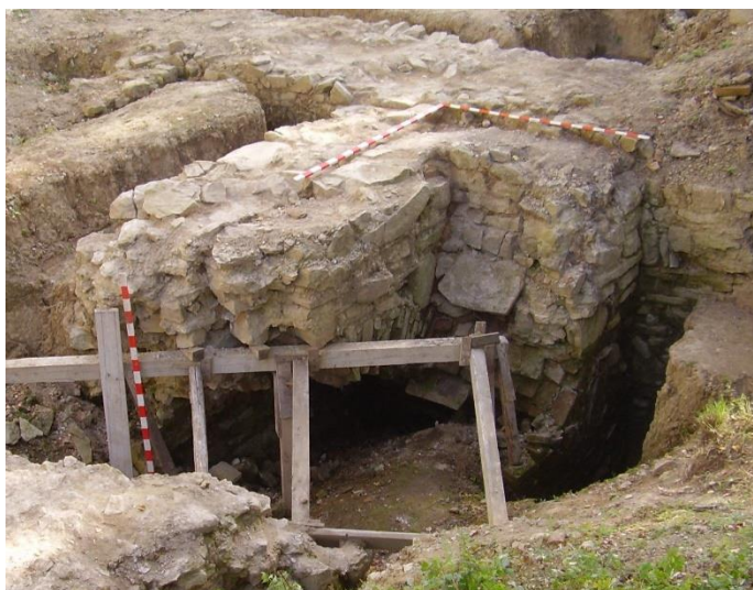
Obr. 25. Stropkov – Hrad. Narušený suterén a základy hradných múrov.
