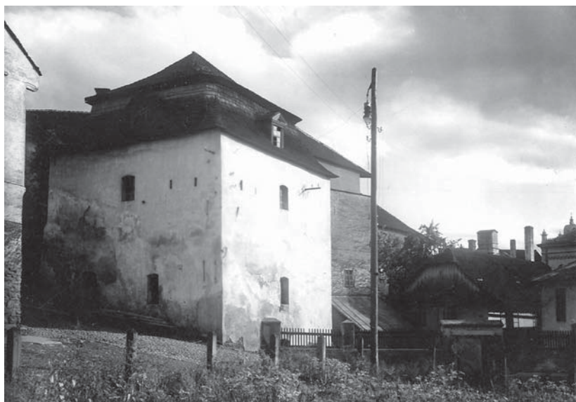
Historická bašta stredovekého mestského opevnenie v Prešove, prebudovaná na vodnú vežu (Wasser Turm), dnes známa ako Kumšt K príspevkom: Z dejín prešovských vodovodov a Unikátny prešovský Kumšt
